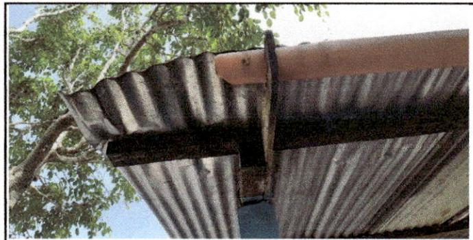
Foto 5: Sustrucción de canal de pvc, sustrucción de bajada de agua pluvial
